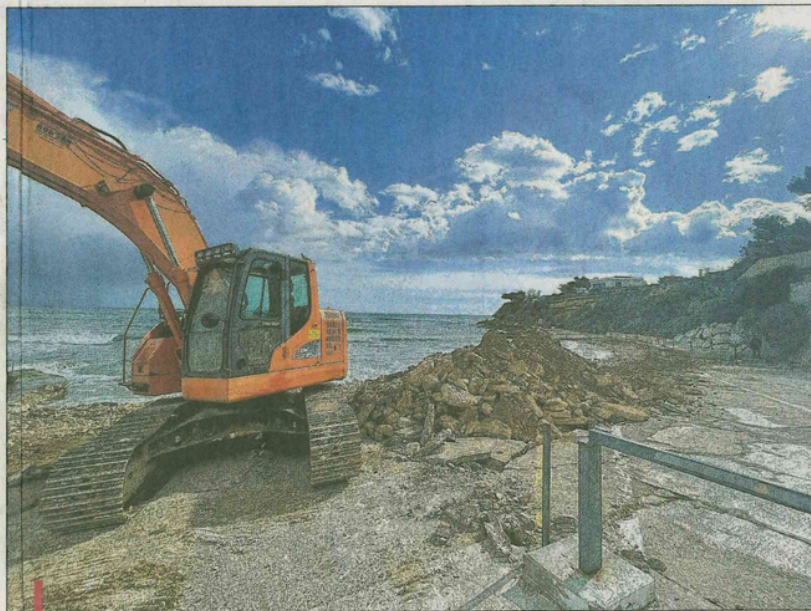
La renaturation et la démolition d'une partie de la dalle béton et de la mise à l'eau de la Tuilière sont réalisés à l'aide d'une pelle hydraulique. /PHOTO J.-L.C.
