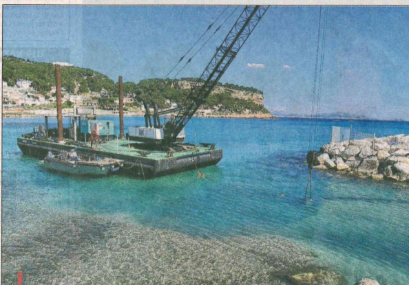
D'importants moyens sont mis en œuvre par la direction des ports MAMP afin de désensabler au plus vite et dans les meilleures conditions le port abri du Rouet.
