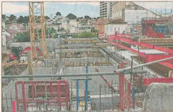
Les travaux sont en cours pour fibrer l'entièreté de la ville d'ici 2020. /PHOTO DR
